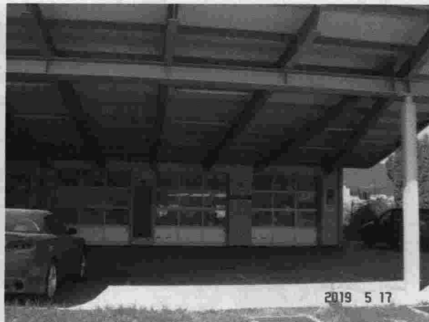
Slika 4: Pogled nanadstrešek z druge strani, kjer so vhodi v servisno delavnico.
