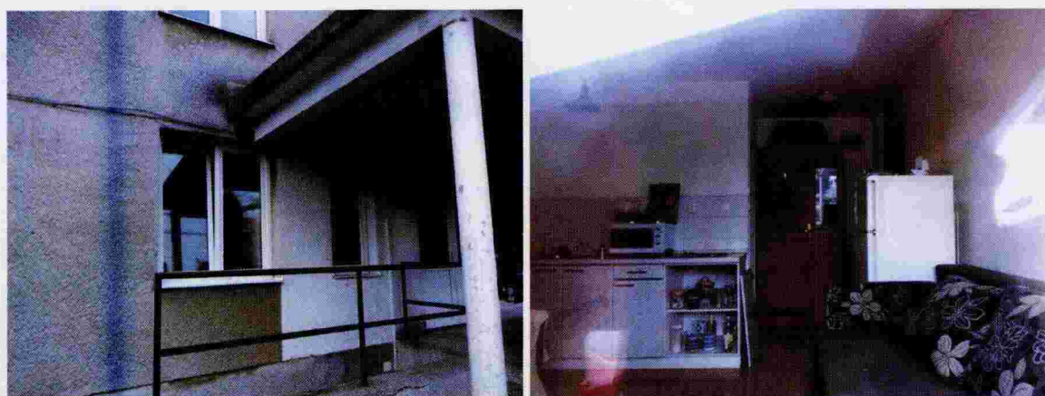
Okno ocenjevanega stanovanja (levo od vhoda-dvojno okno) in pogled v notranjost skozi okno
