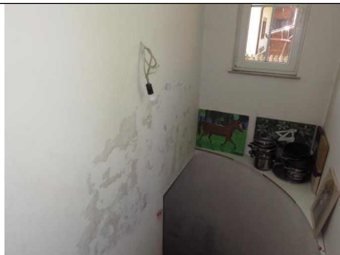
Klet-stopnišče ( prisotnost vlage- na zidovih vidni znaki )
