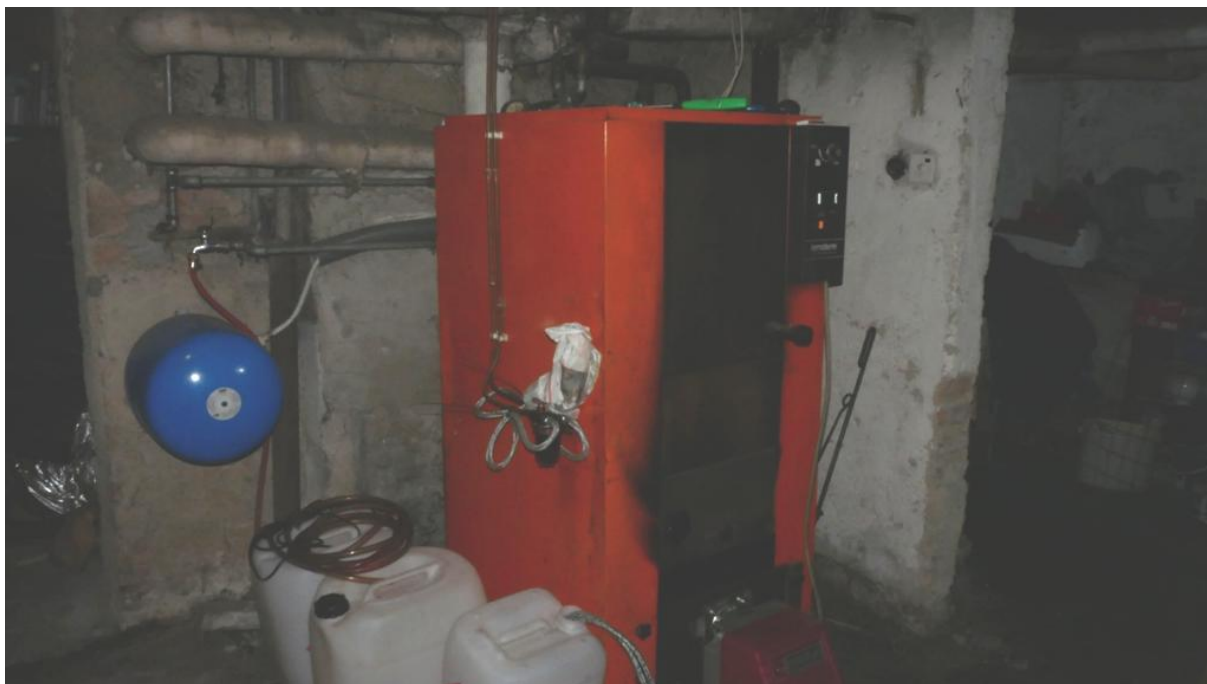
Slika 19: peč centralnega ogrevanja v kleti
