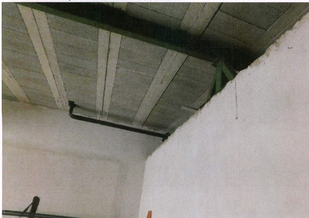
STROP JE NEOBDELAN, STENE NISO POZIDANE DO STROPA
