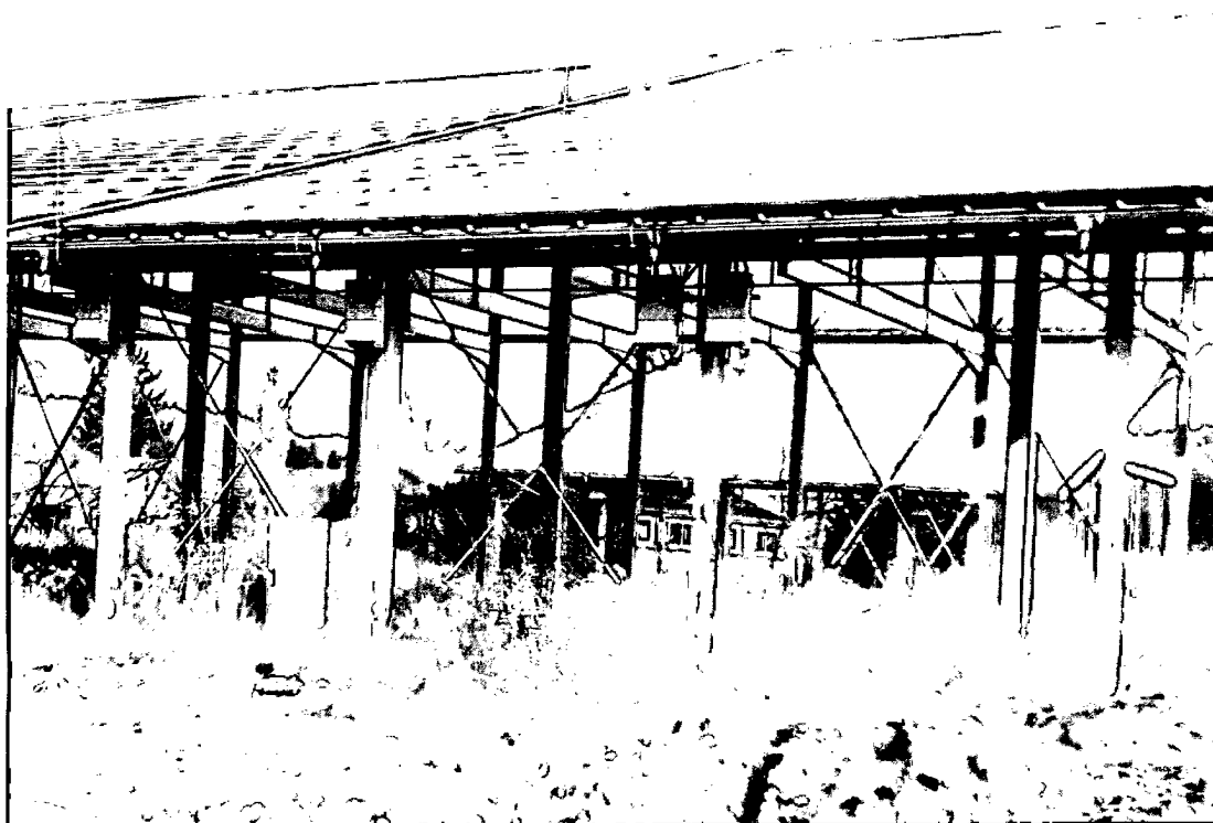
Slika 9 Prikazuje neustrezno položitev DC vdov (kablji potekajo kar okoli žlebov)
